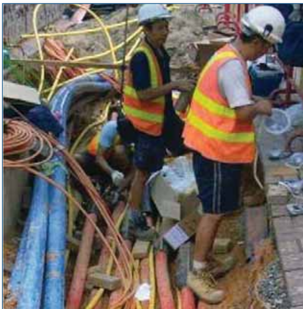
Fig. 10 Una trincea scavata per i sotto-servizi
