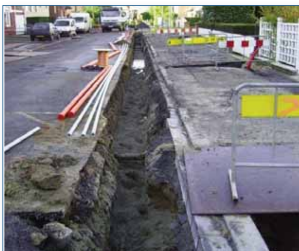
Fig. 1 Lo scavo di una trincea in ambiente urbano
