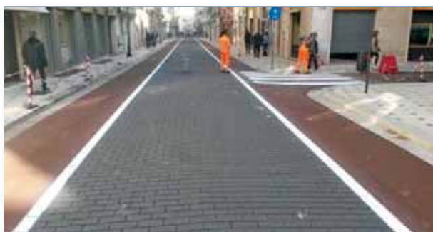
Fig. 5 Resinatura e segnaletica
