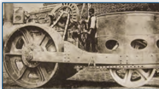
Rullo compressore a vapore inglese del 1864
