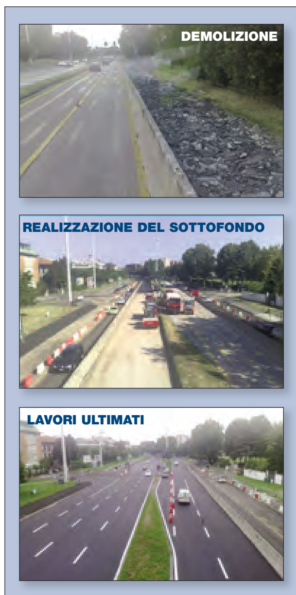
Fig. 4 Fasi di intervento in V.le E. Fermi
