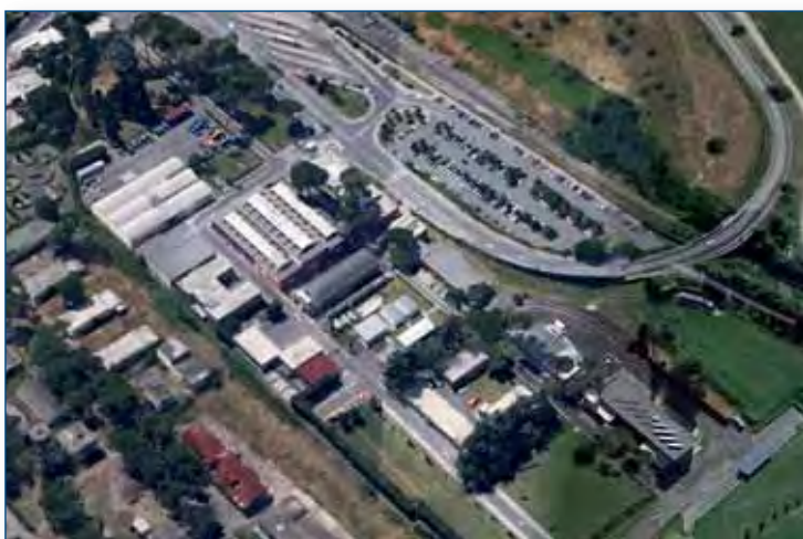
Il Centro Sperimentale Stradale visto dall'alto
