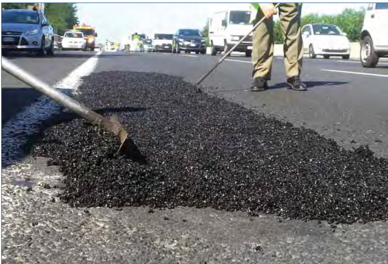
FIG. 13 Miscela a freddo applicata per chiudere una buca
