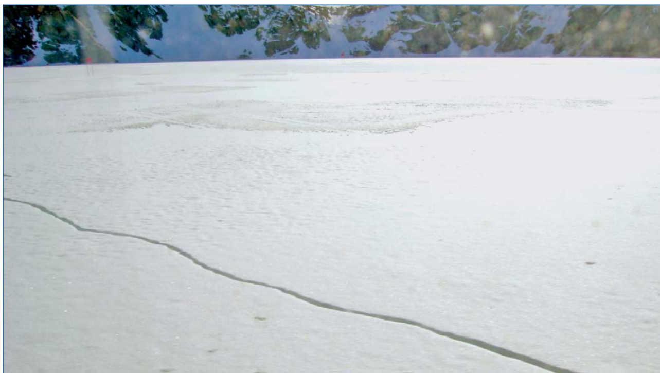
Prime lesioni sul pack e interdizione all'attività volativa della pista in ghiaccio
