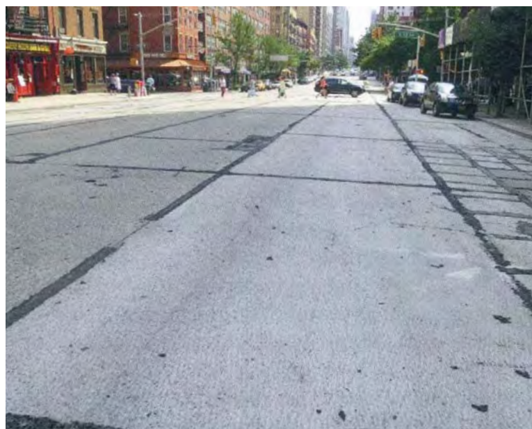
Fig. 7 First Avenue: sigillatura delle fessure dopo la microfresatura e prima della ripavimentazione
