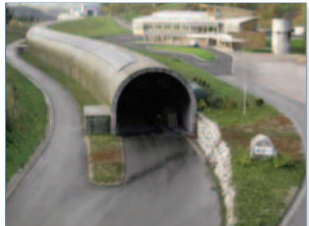
Fig. 3 Sezione e immagine del tunnel di prova
