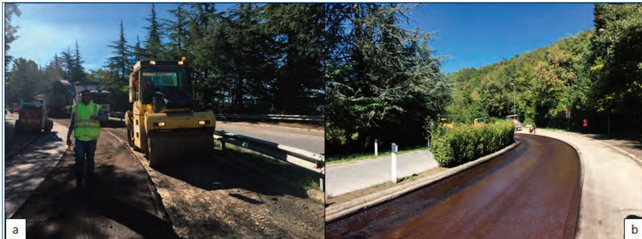
**Fig. 10** Fresatura e compattazione della vecchia fondazione (a); impregnazione della vecchia fondazione (b)
