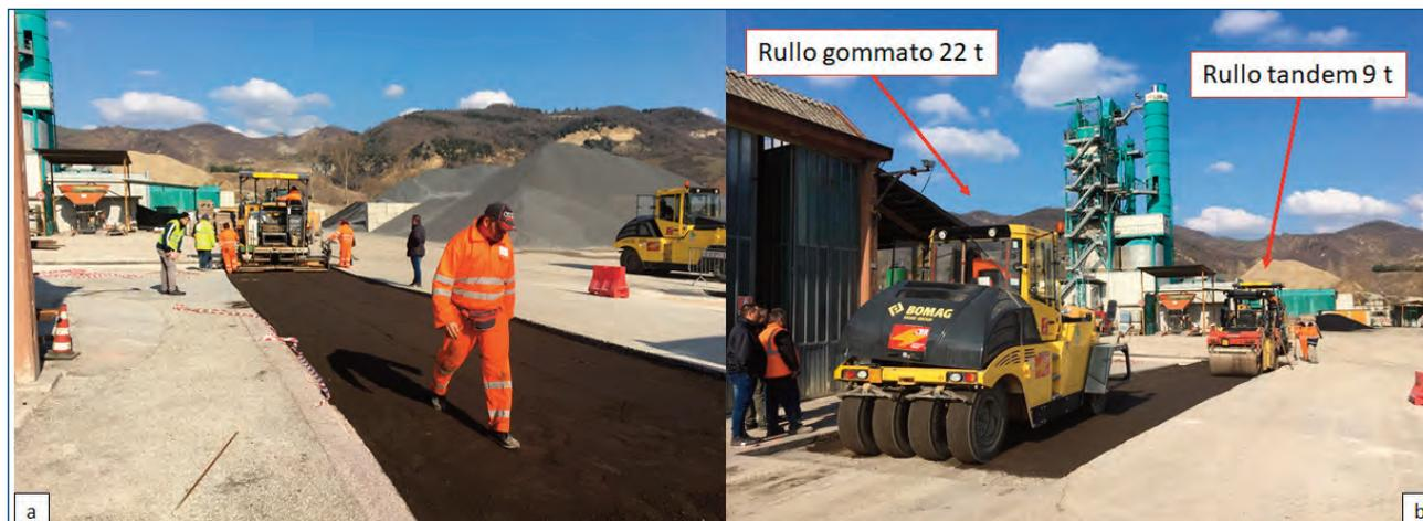
**Fig. 5** Realizzazione dello strato di binder riciclato a freddo: stesa (a), compattazione (b)
