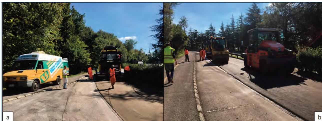
**Fig. 11** Stesa (a) e compattazione (b) del conglomerato bituminoso riciclato a freddo per strato di binder
