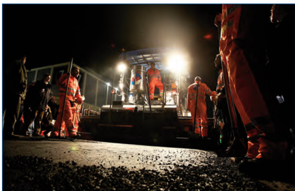
Fig. 16 La stesa sperimentale di asfalto tiepido fatta in notturna (Asphaltica 2006)
