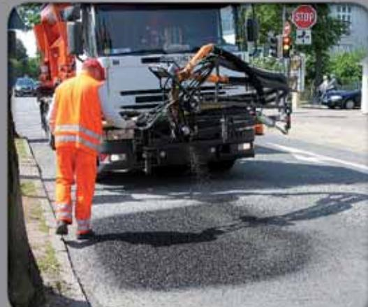
*La Strassmayr STP 1008 è il miglior esempio di macchina per la riparazione delle buche su strada! Grazie alla tecnologia Blow Patcher la riparazione delle buche avviene in modo rapido ed economico, senza bisogno di impiegare ulteriori macchine quali rulli vibranti, frese, finitrici o cisterne spruzzatrici.*
