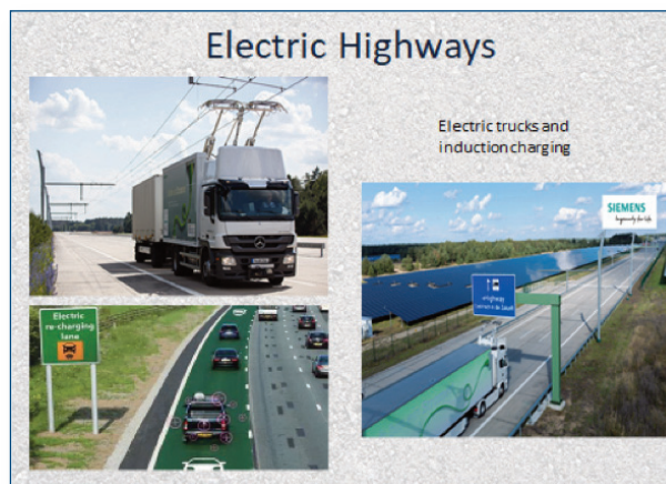
Fig. 1 Le future "autostrade elettriche"
