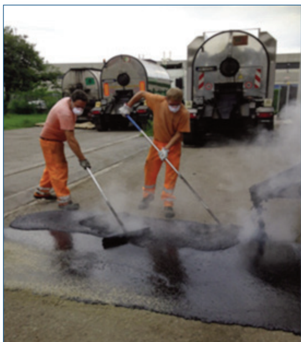
Fig. 3 Lavori di posa manuale dell'asfalto colato
