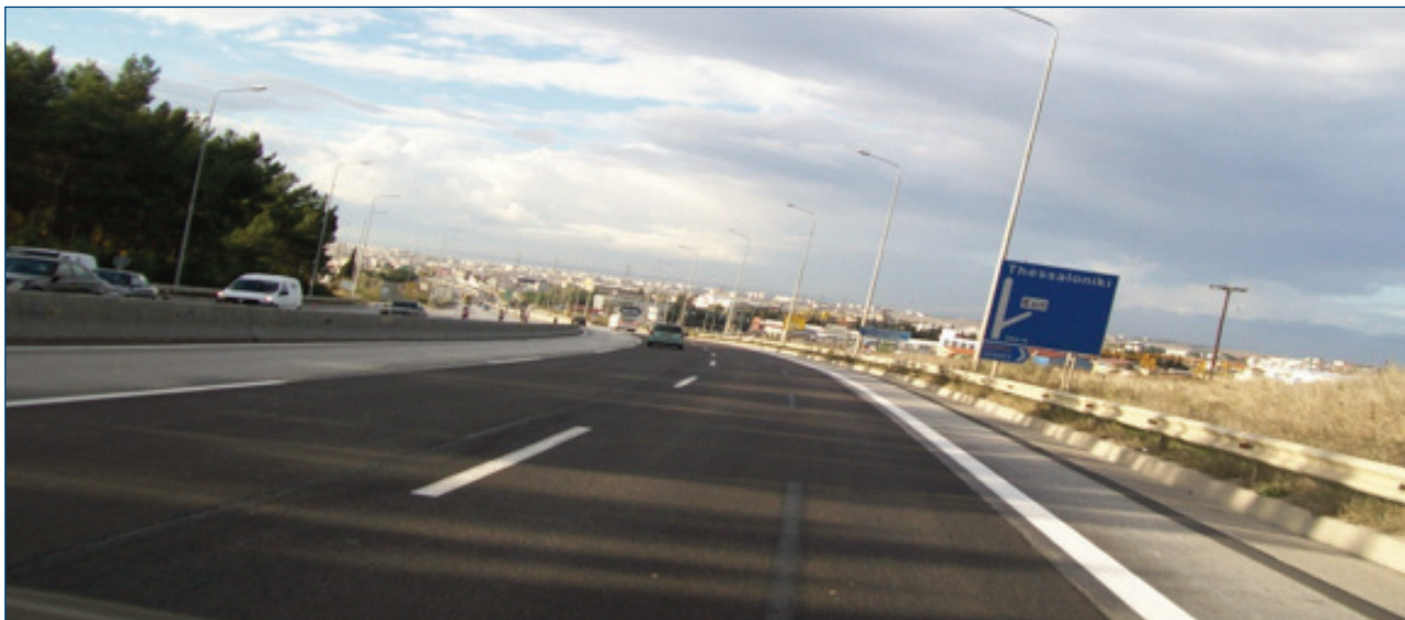
Fig. 3 Autostrada A8 "Olimpia Odos", Grecia
