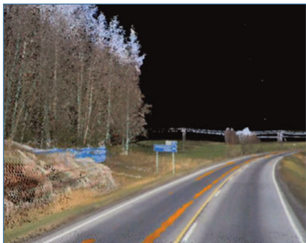
Fig. 8 Ricostruzione di una sede viaria attraverso il laser-scanner (tratto da Heikkilä et. al., 2015)
