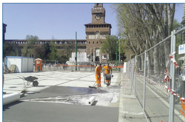
Fig. 5 Lavori presso il cantiere Expo di Piazza Castello
