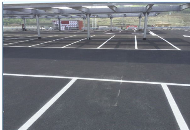
Fig. 4 Piazzale parcheggio auto Serravalle Outlet
